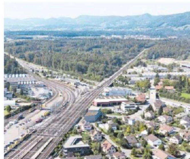
Betroffen sind die Überführungen der SBB und des Rapperswilerwegs über die Autobahn A1 hier genau in der Bildmitte. Bild: Michael Küng
